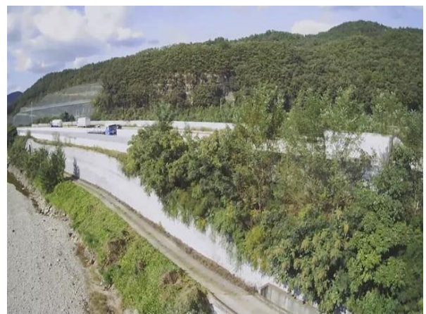
상부 성토부 전경
