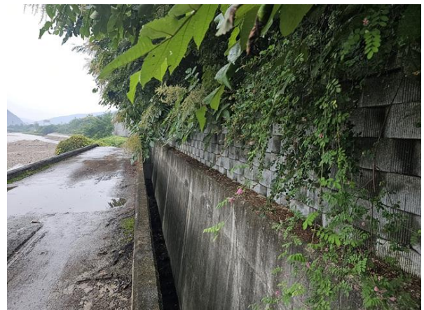
하부 배수로 전경
